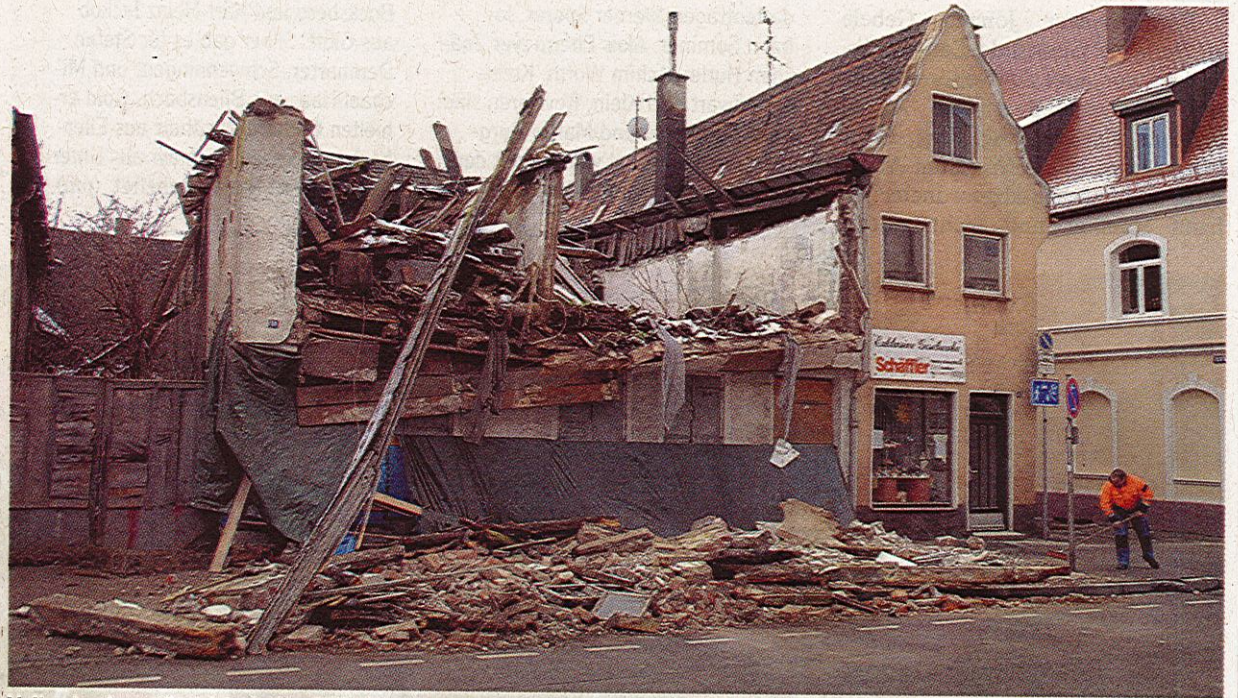
Vollends eingestürzt ist ein baufälliges und seit Jahren unbewohntes Haus in der Lauinger Herzog-Georg-Straße am gestrigen Morgen.
